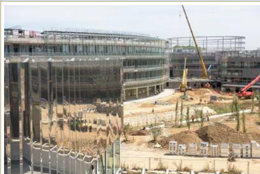
Le chantier d'EDF
